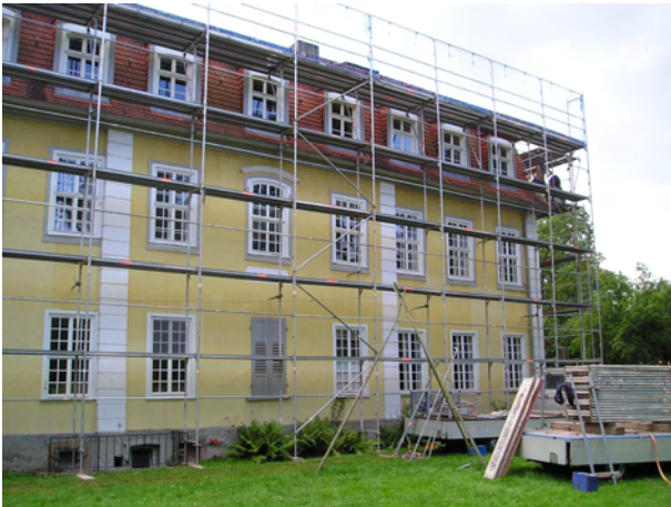
Das Herrenhaus (Rückseite) mit Gerüst
